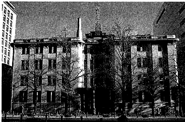
三井物産横浜ビル：明治43年竣工(1910年)築113年 改修済み
