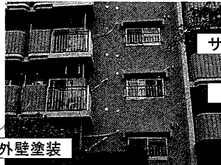
手摺横バー不良部のみ取り換え
