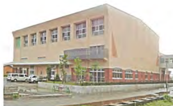
市立裏館小学校 校舎 (2012.8 新潟県三条市) 施工面積：2,500㎡ 設計・監理：大宇根建築設計事務所 元請会社：水倉・梓・マルモJV
