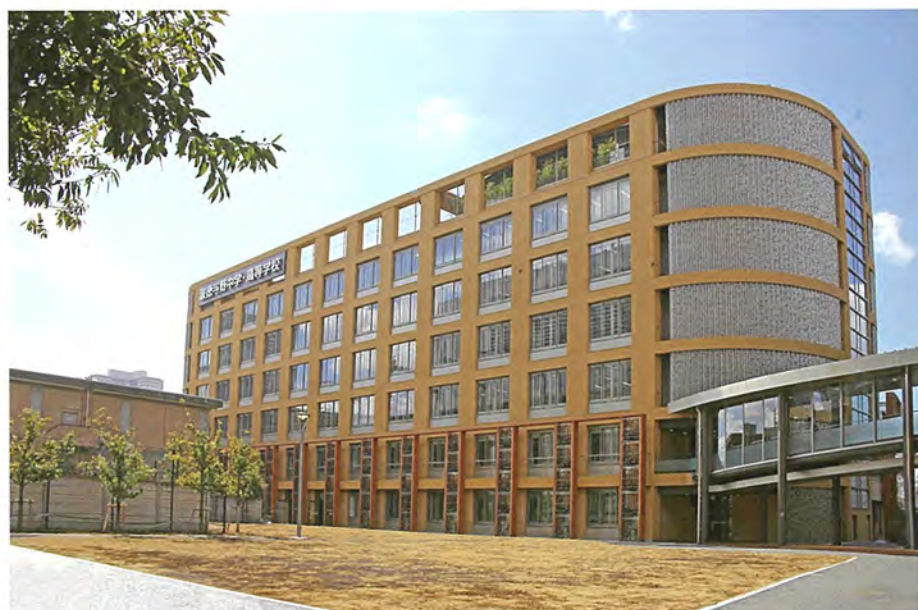
学校法人 大乘淑徳学園 淑徳与野中学・高等学校 校舎 (2015.2 さいたま市中央区) 施工面積：1,670㎡ 設計・監理：佐藤総合計画 元請会社：鉄建建設
