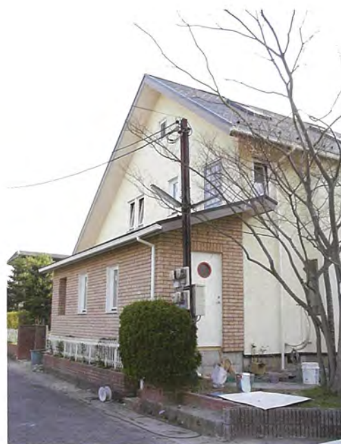
K邸改修 (2004.3 滋賀県高島郡) 施工面積: 140㎡ 設計: アーキ・デレクションズ 施工: 橋本ハウジング
