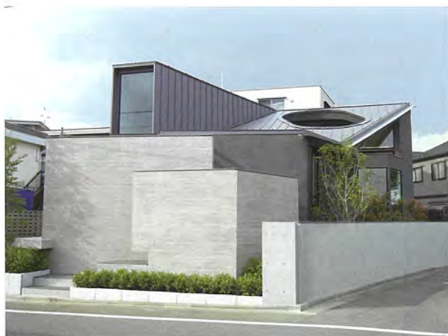
高野台の家 (2011.3 東京都練馬区) 施工面積: 150㎡ 設計: 中村弘道・都市建築計画設計研究所 施工: 平成建設
