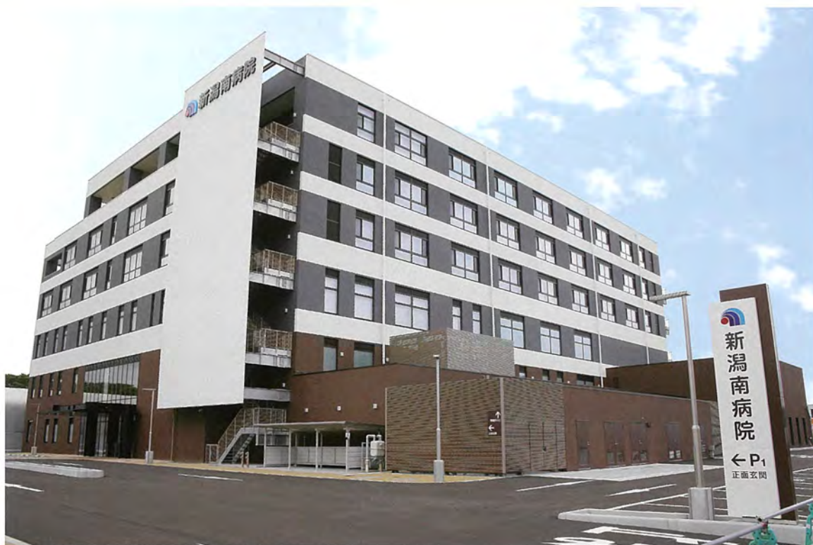
医療法人恒仁会 新潟南病院 (2018.7 新潟市中央区) 施工面積: 5,718㎡ 設計・管理: 山下設計 元請会社: 本間組 「ネット・ゼロ・エネルギー・ビル(ZEB)実証事業」
