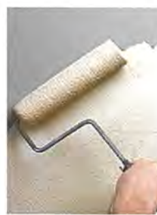
プライマー塗布
