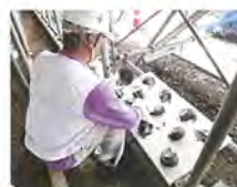
断熱材の接着
