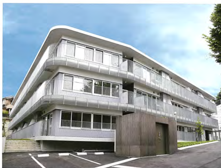
フロール横浜山手 (2015.6 神奈川県横浜市) 施工面積：1,974㎡ 設計・管理：株式会社飯田善彦建築工房 元請会社：株式会社松尾工務店 「第60回 神奈川建築コンクール最優秀賞」受賞
