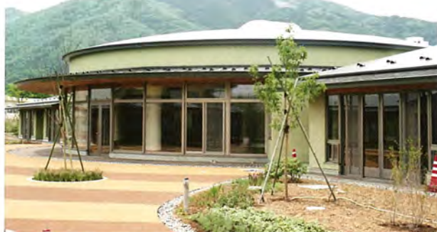
県立あけぼの医療福祉センター 重症心身障害児施設棟 (2006.3 山梨県韮崎市) 施工面積：3,000㎡ 設計・監理：佐藤総合計画・斉藤・中西・興水JV
