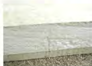
断熱材(EPS)接合部(拡大写真)
