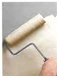
プライマー塗布
