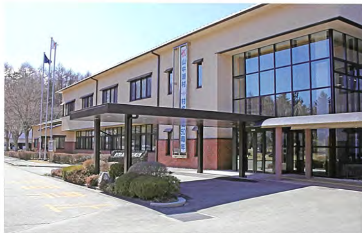
役場庁舎 改修工事 (2015.1 山梨県山中湖村) 施工面積：1,000㎡ 設計・監理：大宇根建築設計事務所 元請会社：川上建設
