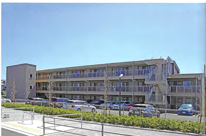
富士重工業 深大寺社宅 (2014.12 東京都調布市) 施工面積：2580㎡ 設計・監理：You & You建築設計 元請会社：小原建設
