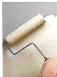
プライマー塗布
