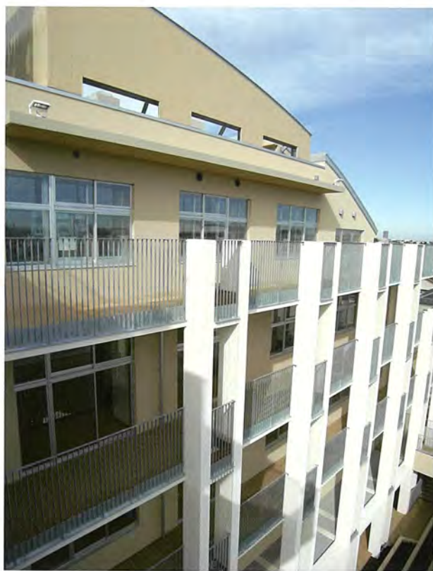
区立天沼小学校 校舎 (2010.8 東京都杉並区) 施工面積：5,600㎡ 設計・監理：佐藤総合企画 元請会社：興建社・大塚・矢島建設JV
