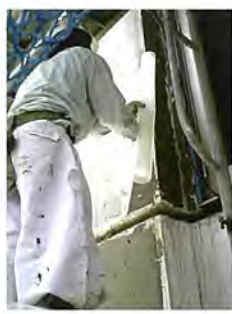
ベースコートによる グラスファイバーメッシュ 伏込み
