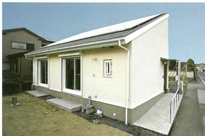
さいたまパッシブハウス15 (2009.12 さいたま市見沼区) 設計・施工：ハイシマ工業 国土交通省 住宅建築関連先導技術開発助成事業
