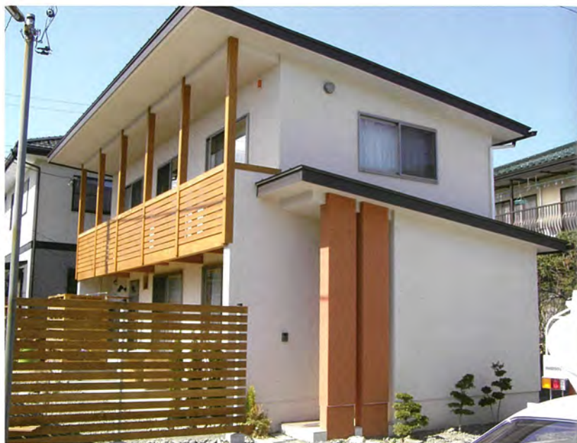
K邸 (2006.2 山梨県南アルプス市) 施工面積：150㎡ 設計：河野建築設計事務所 施工：松土建設興業
