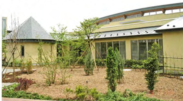
県立あけぼの医療センター 肢体不自由児施設棟 (2006.3 山梨県韮崎市) 施工面積：2,000㎡ 設計・監理：佐藤総合企画・井口・山市JV
