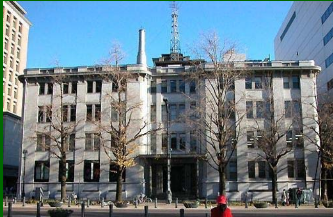
三井物産横浜ビル：明治43年竣工(1910年) 105歳 改修済み
