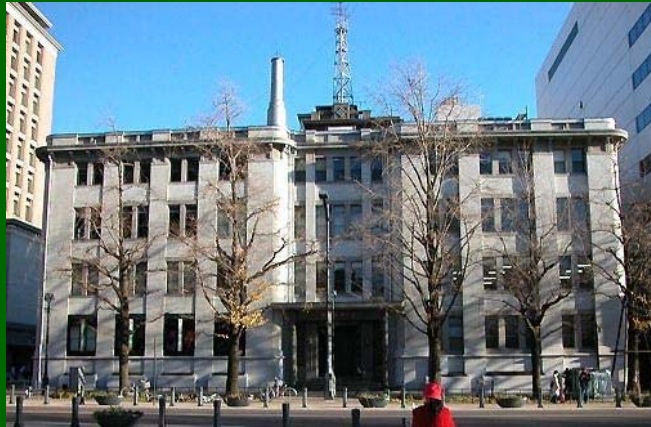
三井物産横浜ビル：明治43年竣工(1910年) 105歳 改修済み
