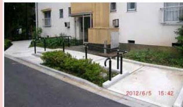
玄関アプローチのバリアフリー事例 （国土交通省・持続可能社会における既存共同住宅ストックの再生に向けた勉強会資料より）
