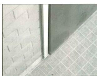
2 玄関ドアの変形(本体が反り、枠からはみ出している。開閉に支障がある)
