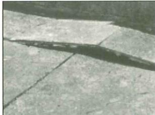
2 保護コンクリートの損傷（膨脹し、せり上がった）
