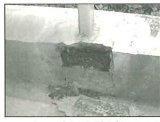
3 スチール手すり取付け部コンクリートの破損（軸体内の取付けプレートがさび、コンクリートがはがれた）
