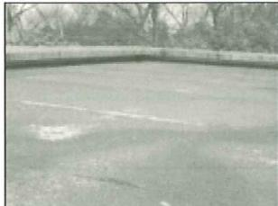
1 アスファルト露出防水の保護塗装の損傷（経年により表層の紫外線保護の砂が落ち、シートの基材が白く出ている）
