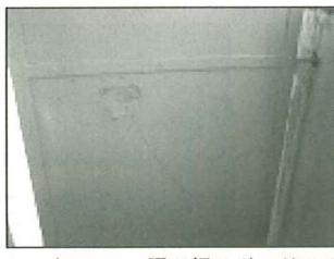
4 バルコニー隔壁のボードのひび割れ
