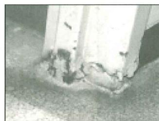
5 共用廊下の防火戸の枠の腐食
