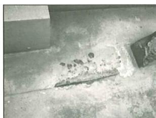
3 露出防水のふくれ（防水層裏側に雨水がまわり、押すと水が出てくる）
